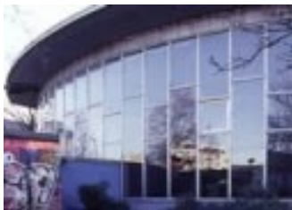
▲ Eingang zum Tränenpalast. Der so erfolgreiche Kulturbetrieb mußte dort aufgegeben werden. (Repro: 2004 – khd)
